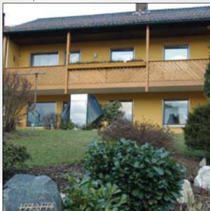
Aria/acqua esterna 15 kW
